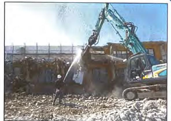
散水を行って粉塵を抑え込みながら解体作業を行う様子
